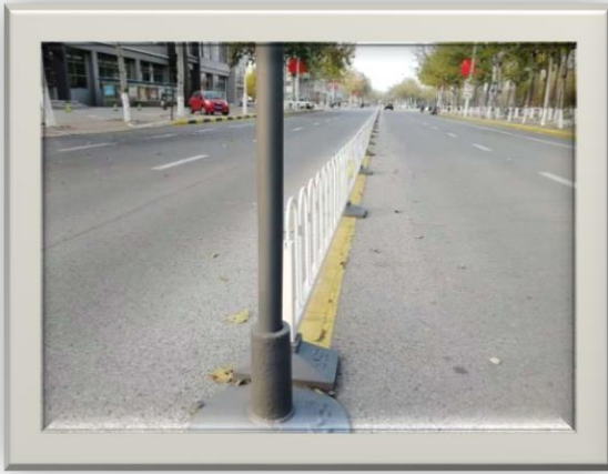
完成天勤路隔离护栏除锈涮漆
